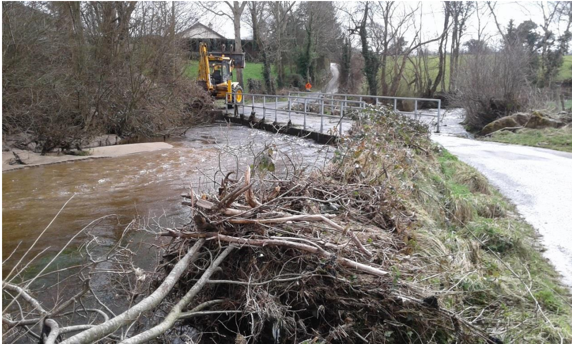
Smionagar á ghlanadh ó dhroichead le haghaidh measúnú struchtúrtha a dhéanamh.
